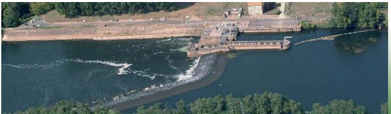
La passe à poissons de Bergerac. Le barrage coupe le lit de la Dordogne dans sa largeur. En amont du barrage, on peut apercevoir une drome flottante (en haut à droite de la photo) dont le but est de détourner les débris et objets flottants, afin qu'ils n'obstruent ni les grilles de protection des turbines, ni l'entrée de la passe à poissons. © Alain Bordes / EPIDOR
