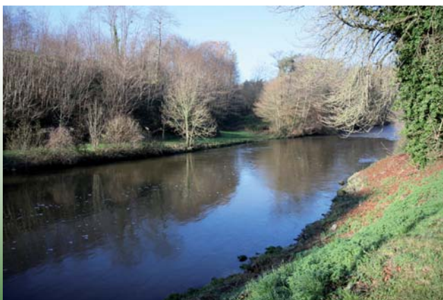
Le cours de la Sélune est perturbé par deux barrages hydroélectriques, Vezins et la Roche-qui-Boit. © B. Rousseau
