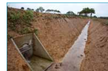
Rectification, recalibrage et drainage sur le ruisseau de l'étang à Availles Limouzine, mai 2008 (86) - © Michel Bramard
