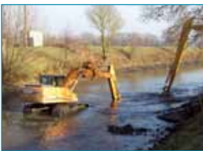
Travaux sur l'Authion (49) © Vincent Molinier
