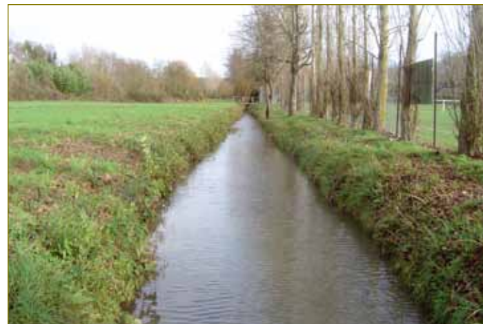
Le Marolles rectiligne à Génillé avant travaux (37) © Jonathan Leproult
