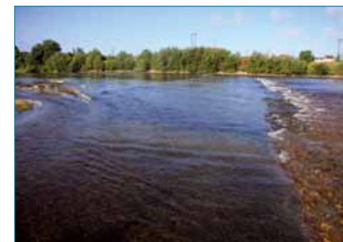
Seuil noyé à l'endroit de l'ancien barrage de Maisons rouges, juillet 2008 (37) © Michel Bramard
