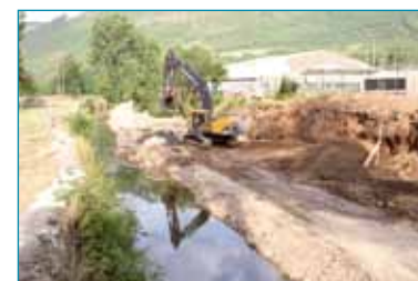
Travaux au camping de Mende en 2006 (48) © Bernard Rousseau
