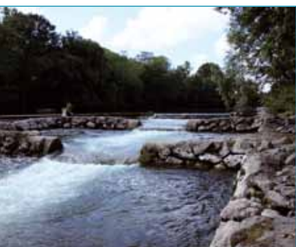
Passes à bassins successifs sur le Gave d'Oloron à Navarrenx, juillet 2009 (64) © Bernard Rousseau
