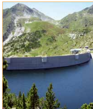
Barrage et retenue du Lanouz, juillet 2008 (66) © Romain Suaudeau
