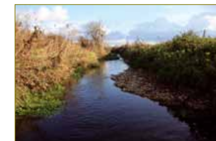
Le lit de la Céphons après travaux en novembre 2009 (36) - © Michel Bramard
